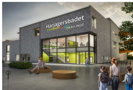
Johan Ericsson, ordförande i Arbetsliv och fritidsnämnden och kommunstyrelsens ordförande Pia Almström tog det första spadtaget för Kävlinge kommuns nya badhus i april. Harjagerbadet kommer bli ett badhus på tre våningar med något för alla.
