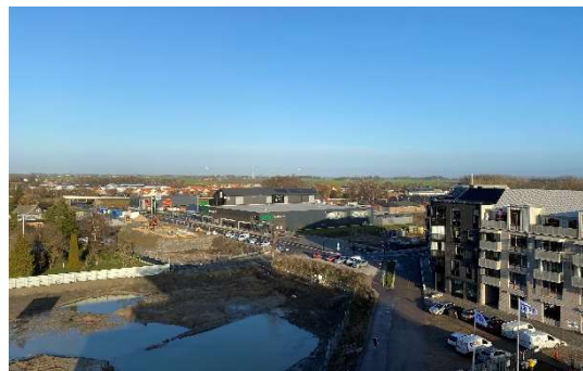
Utsikt över Stationsstaden från bygget av nya Kommunhuset. December 2021.
