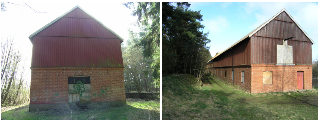
T.v. västra gaveln, t.h. östra gaveln.
