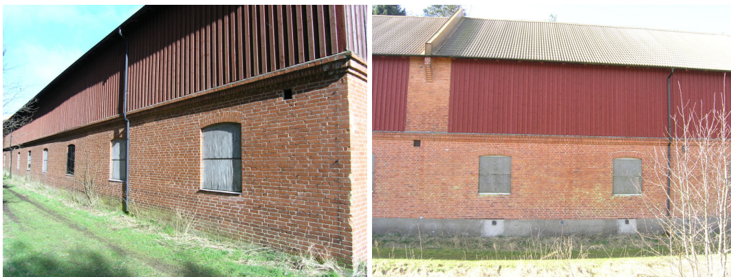
T.v. södra långsidan, t.h. parti av norra långsidan med brandgaveln som delar byggnaden i två.
