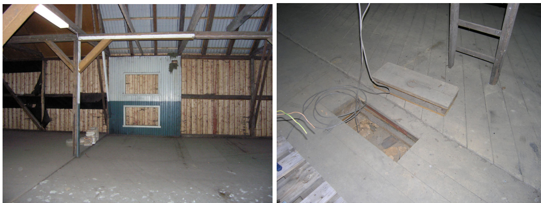
T.v. äldre väggsektion finns bevarad i västra delen av vindsplanet. T.h. ventilationsluckor i vindsbjälklaget, i bild syns även körbanan av skråställda plank.
