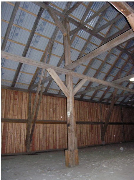
Takstolen på dubbla rader av träpelare. Invid pelaren syns ventilationskanal från bv. T.b ventilation..
